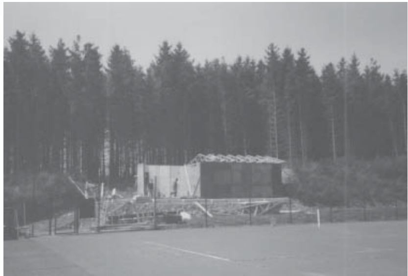
Dank des freiwilligen Einsatzes der Helfer ging der Aufbau zügig voran.
